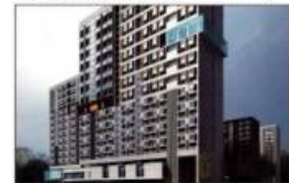
学生宿舍 (职工)公寓 Dormitory
