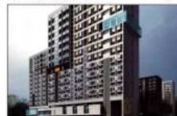
学生宿舍 (职工)公寓 Dormitory
