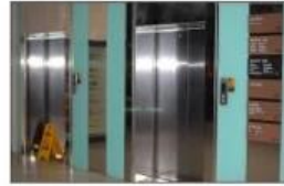
电梯控制器Elevator controller
