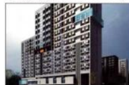
学生宿舍 (职工)公寓 Dormitory
